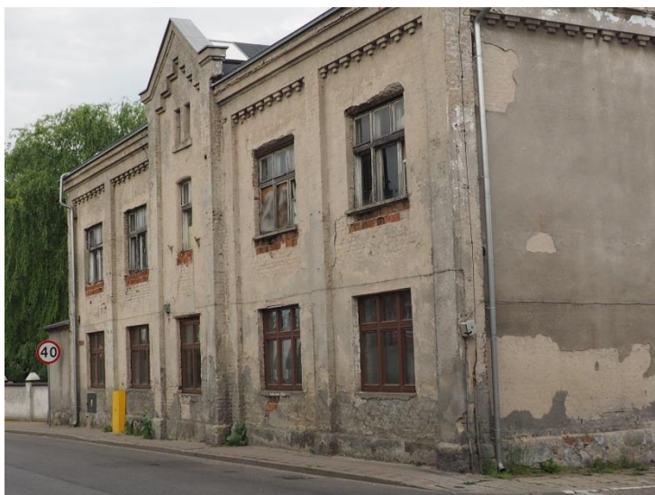
Zdjęcie 2. Budynek przy ul. Szkolnej w Łasinie
