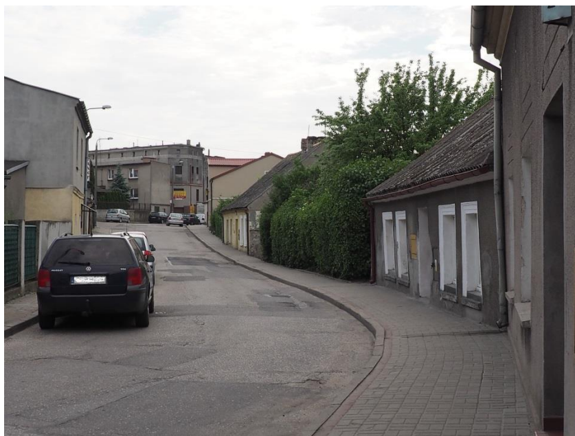
Zdjęcie 1. Przykładowe drogi wymagające modernizacji – ul. Podmurna
