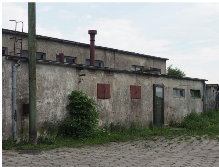
Zdjęcie 5. Przestrzeń zdegradowana – budynek po kotłowni osiedlowej
