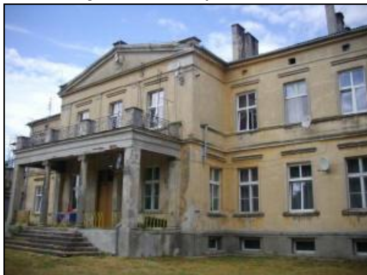
Fotografia 6. Pałac w Szynwałdzie.
